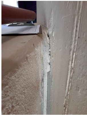
Unión de Baranda, 2ndo piso
