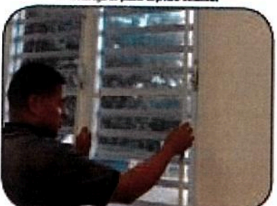
Instale o repare la malla o tela metálica de ventanas y puertas.
