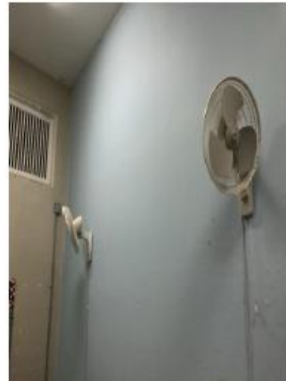
Ilustración 22. Reemplazo de abanicos
