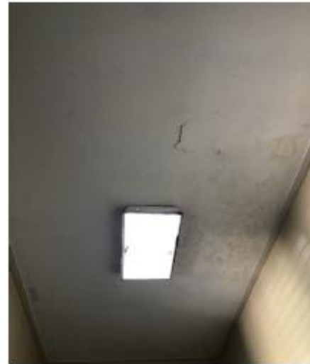
Ilustración 6. Reparar y empañetar
