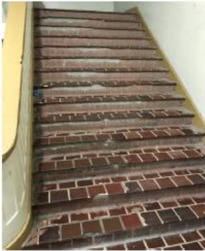
Ilustración 13. Arreglar los bordes de las escaleras
