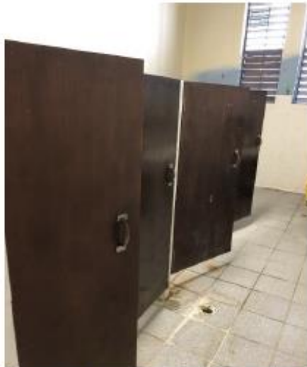
Ilustración 11. Reemplazar las puertas de los baños
