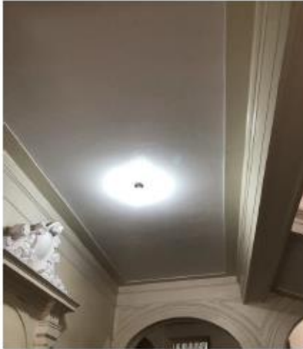
Ilustración 1. Instalación de focos
