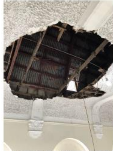
Ilustración 26. Techo de pasillo del tercer piso
