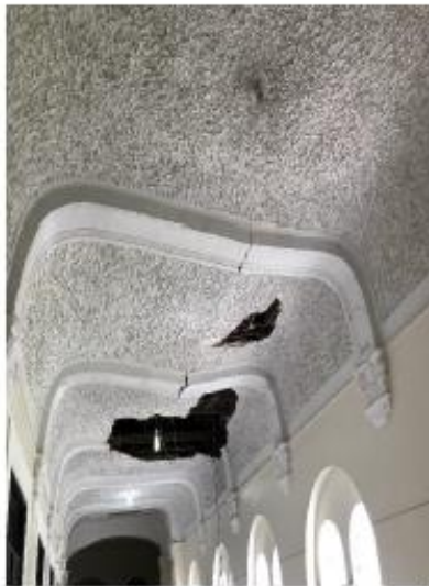
Ilustración 27. Techo del tercer piso
