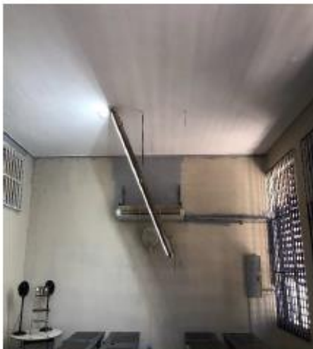
Ilustración 3. Lámparas para reemplazar
