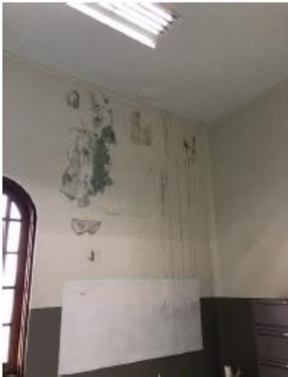
Ilustración 21. Paredes filtrando
