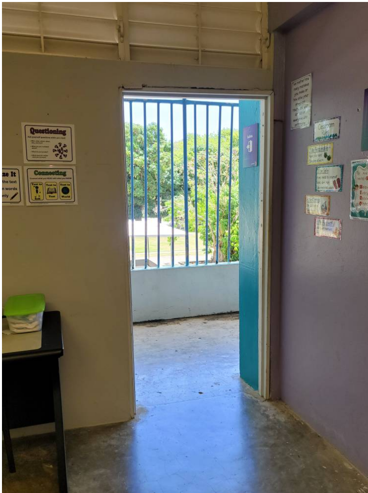
Creado: mar. 24 may. 11:33 2022 Edificio 2 salon 12, (2) puertas de screen
