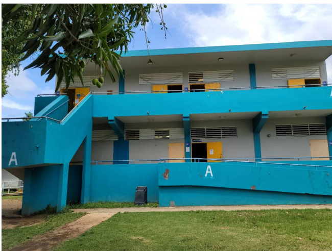
Creado: mar. 24 may. 13:59 2022 Edificio 6
