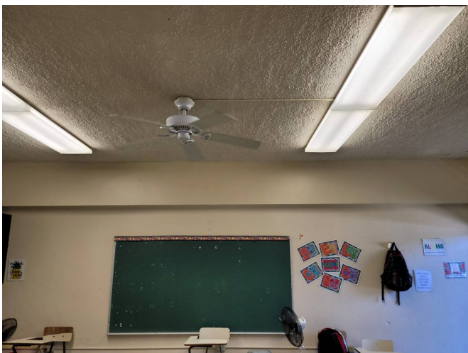
Creado: mar. 24 may. 11:34 2022 Edificio 2 salon 12, instalacion de aire acondicionado 36k BTU
