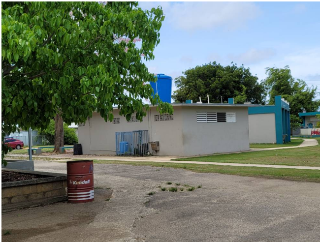
Creado: mar. 24 may. 13:58 2022 Edificio 4
