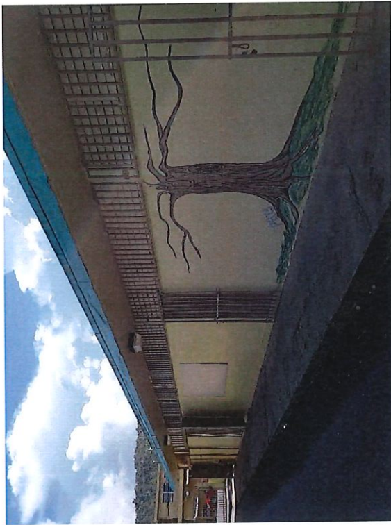
Esc. S.U. Vidal Serrano Inspección Ocular 15 de enero de 2020
