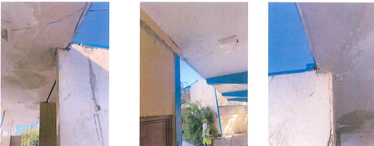
Fotos: Conexión entre techo y estructuras de escaleras.
