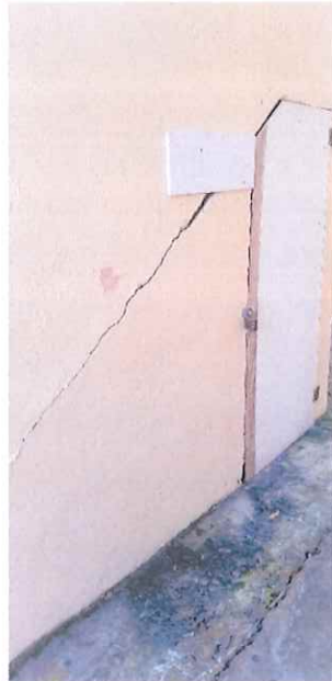
Fotos: Deficiencias en segundo piso y grieta en escalera.
